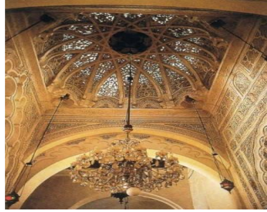
صورة 2: قبة الجامع الكبير بتلمسان وهي عبارة عن مجموعة من الأقواس المتقاطعة وتخللها إضاءة من زخارف ضوء الزخرفة من الأعلى إلى الأسفل بعوارض زخرفية.
